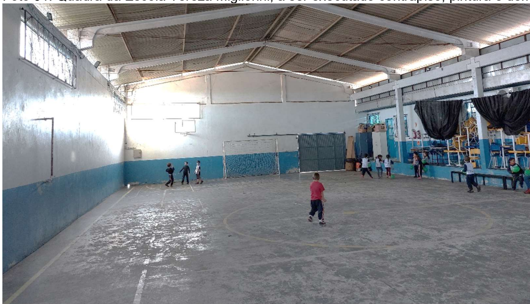
Foto 01: Quadra da Escola Tereza Migliorini, a ser executado contrapiso, pintura e demarcação.
