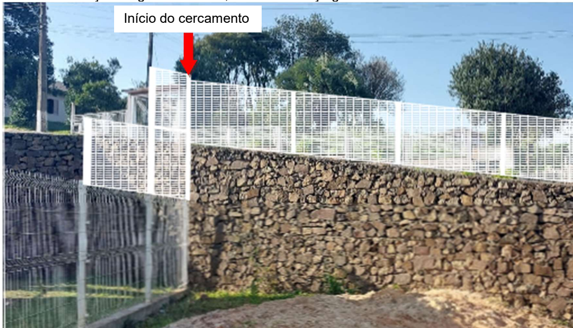
Foto 05: Execução de gradil metálico, com tela de aço galvanizado.
