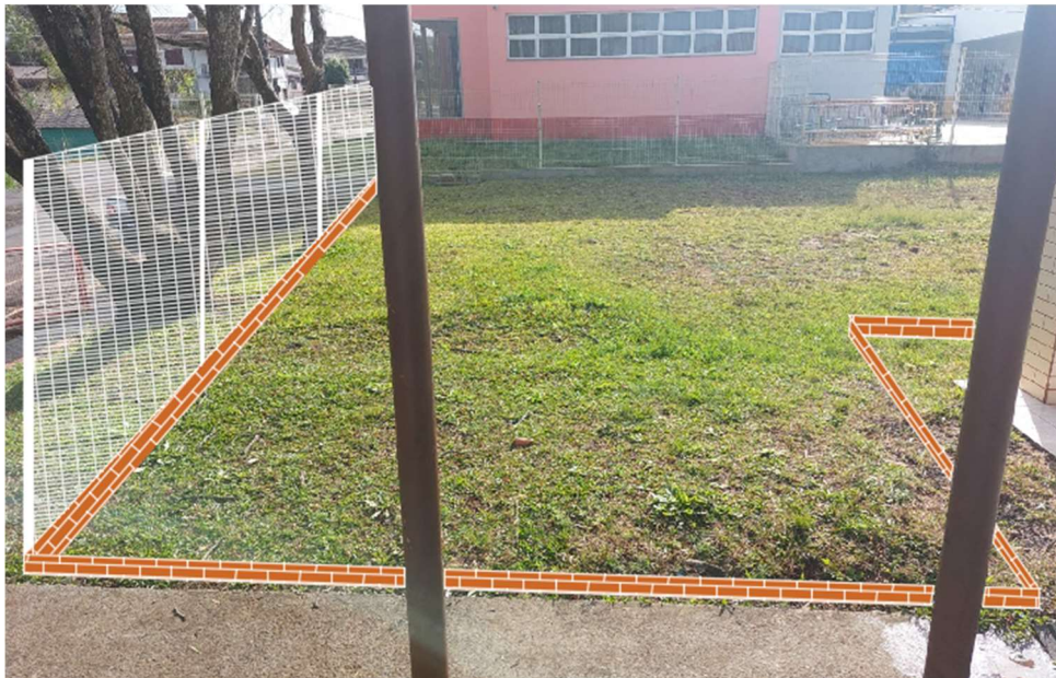
Foto 10: Local a ser executado mureta em alvenaria.
