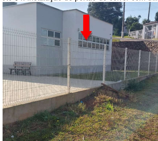
Foto 04: Instalação de portão de correr com trilho.
