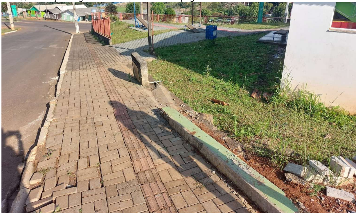
Foto 06: Execução de gradil metálico, com tela de aço galvanizado.
