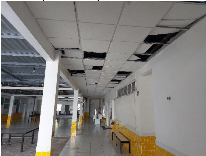
Foto 02: Sala de aula para substituição de Forro
