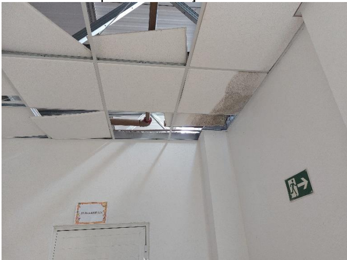
Foto 03: Sala de aula para substituição de Forro
