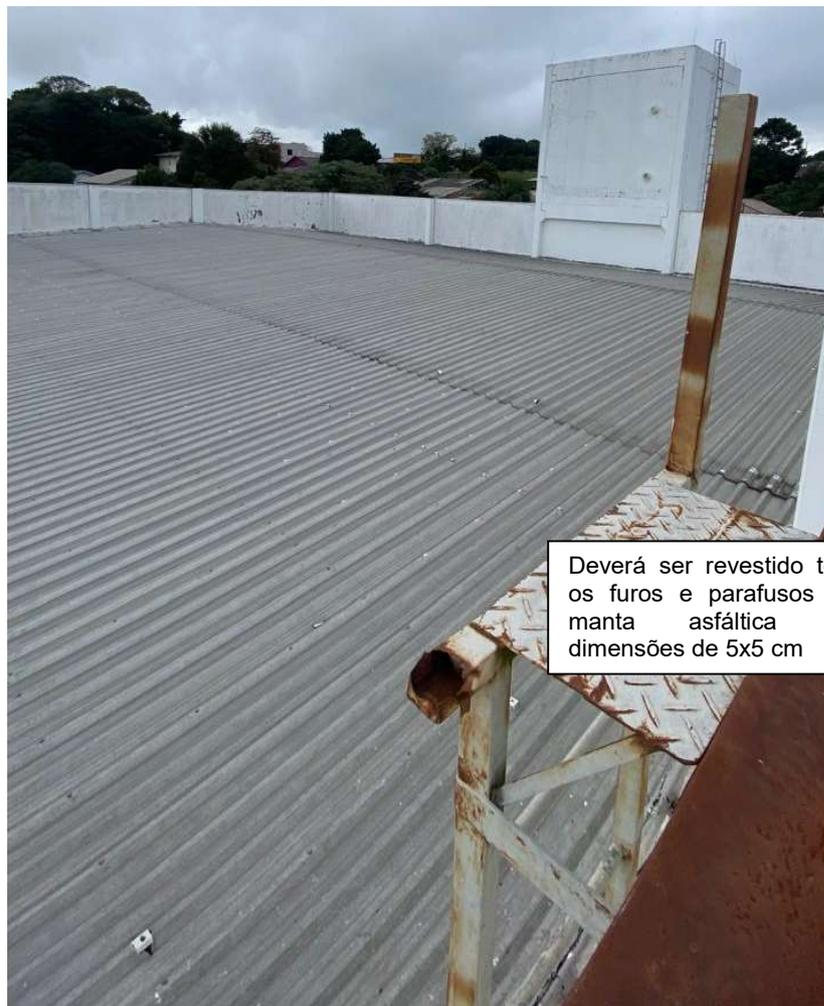
Deverá ser revestido todos os furos e parafusos com manta asfáltica com dimensões de 5x5 cm
