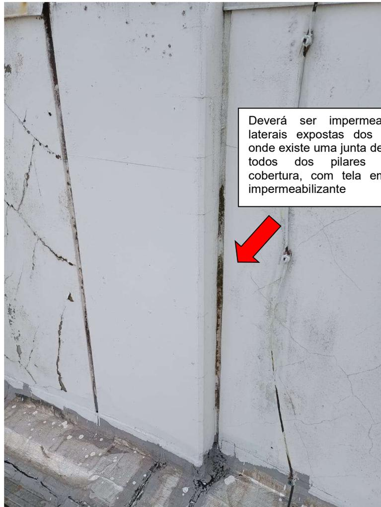
Deverá ser impermeabilizado nas laterais expostas dos pré-moldados onde existe uma junta de dilatação em todos dos pilares internos da cobertura, com tela em poliéster e impermeabilizante
