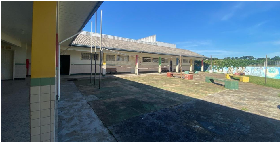
Imagem 08 – Fachada para execução de pintura de paredes.
