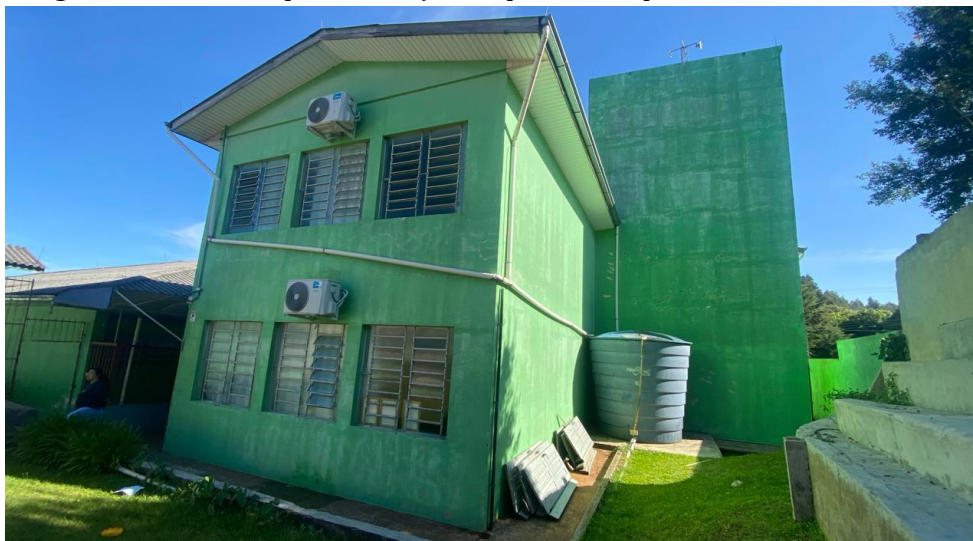
Imagem 07 – Fachada para execução de pintura de paredes e abas.
