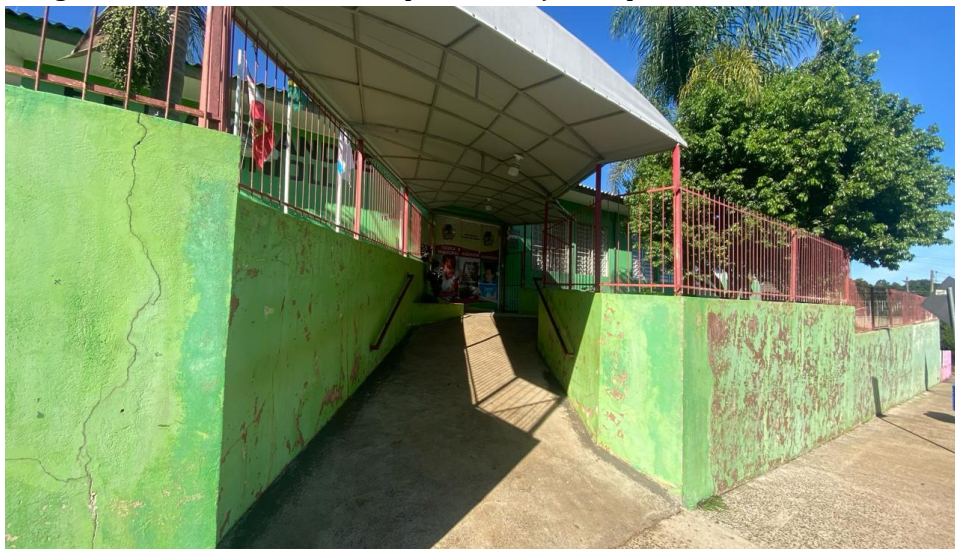
Imagem 04 – Entrada da Escola para execução de pintura de muros e cercas
