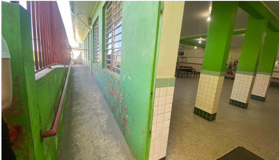
Imagem 05 – Local para execução de pintura de paredes, corrimãos e cercas
