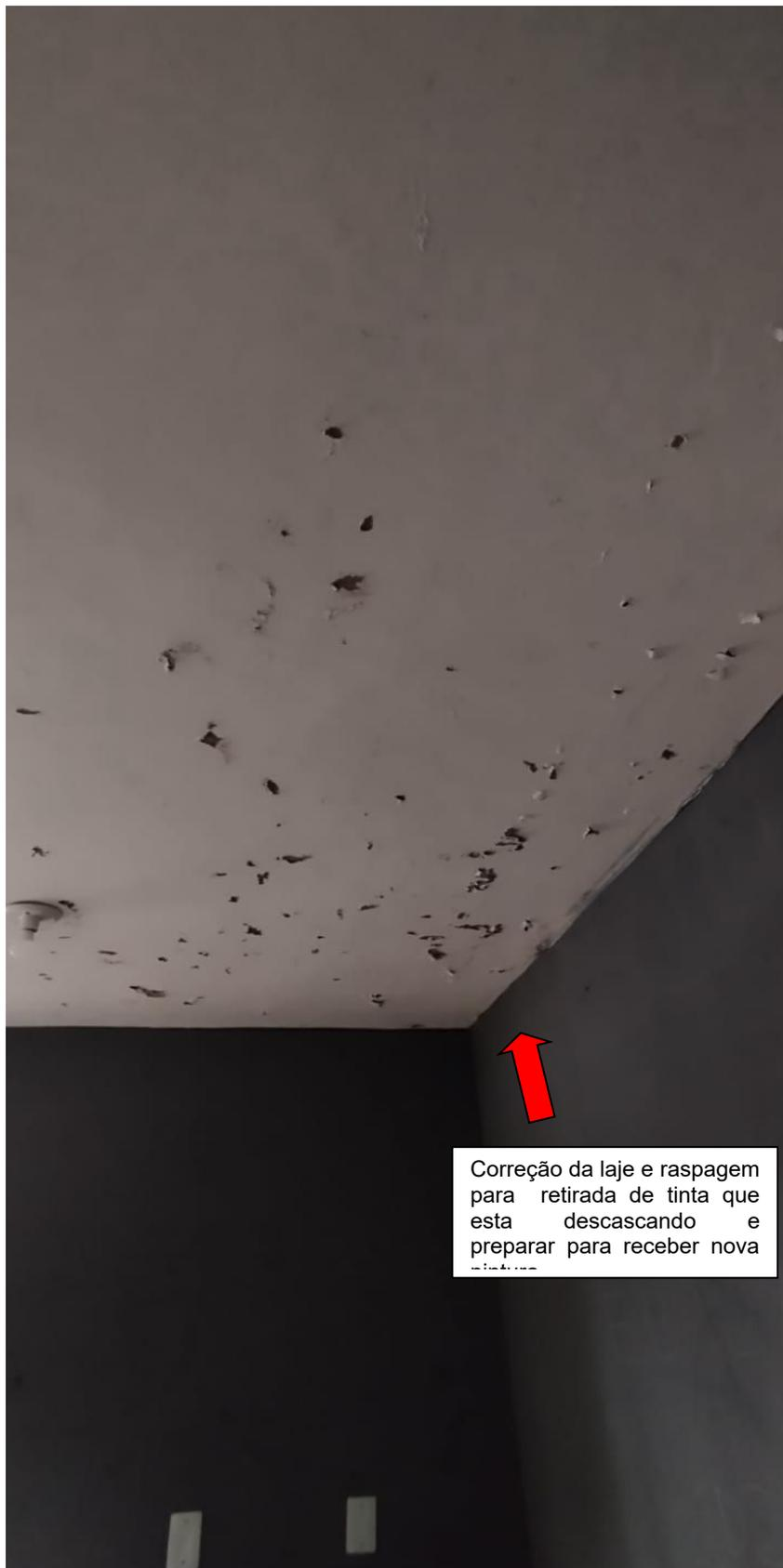
Correção da laje e raspagem para retirada de tinta que esta descascando e preparar para receber nova pintura.
